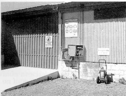
*Portón de entrada al depósito transitorio de transformadores con vista de la advertencia sobre restricción al ingreso, carteles de seguridad, hidrante, tablero externo*
