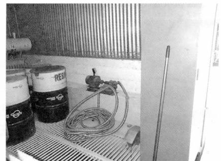
*Interior del depósito transitorio con vista de sensor de nivel, alcantarillas, tambores para residuos y bomba de trasvase de líquido*
