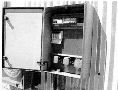
En el ingreso al depósito tablero con los dispositivos de protección, tomacorrientes, y llaves de encendido y apagado de las luces
