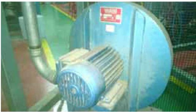
Figura 5. Conjunto ventilador-motor
